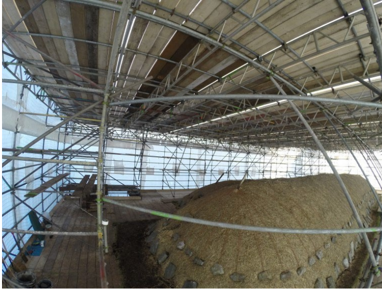
Vue intérieure de l'échafaudage couvert qui a été utilisé lors du dernier processus complet de réfection de la toiture en chaume afin de protéger, entre autres, la collection d'artefacts qui se trouve à l'intérieur.
