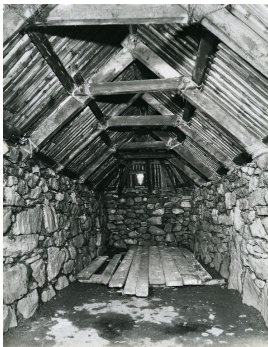
Poutres du toit au-dessus de la grange du n° 42
