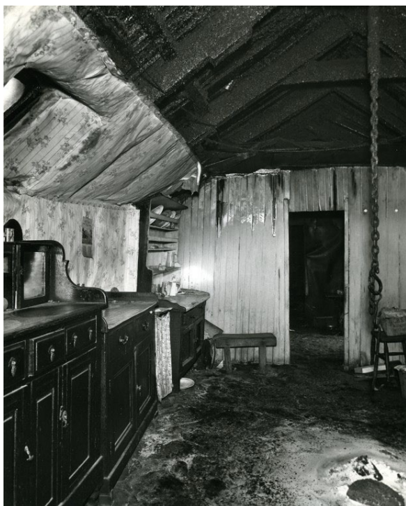
Vue intérieure depuis le salon donnant sur le porche et l'étable
