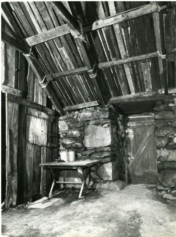
Le porche avec la porte extérieure
