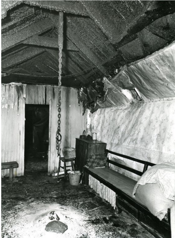
Vue intérieure depuis le salon donnant sur le porche et l'étable
