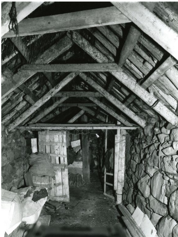
Intérieur de la grange
