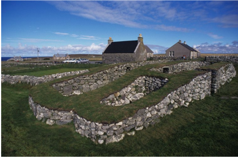
La maison noire en ruine consolidée au n° 39, avec la maison blanche et le bungalow des années 1960 (centre d'accueil des visiteurs) derrière elle.
