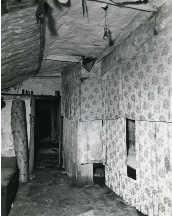
Intérieur de la chambre et des lits coffres (à noter que les murs et les lits sont recouverts de tissu/papier) avec vue sur le salon
