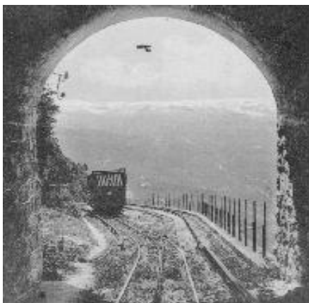
Fig. 35 - Portail aval du tunnel de 119 m de long, large de 3,9 m, de pente 13,5° et orienté à 68° ; au fond, le Vuache enneigé et le Jura ; à gauche les isolateurs des fils du téléphone
