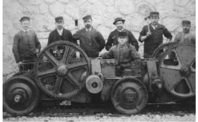
Fig. 06 - Châssis d'automotrice au dépôt d'Etrembières. La vitesse permise sur la pente la plus forte est de 6 km/h ou 100 mètres/minute, correspondant à 50 tours/minute aux pignons, leur cercle primitif ayant une circonférence de 2 mètres et le rapport de réduction des engrenages étant de 1:12
