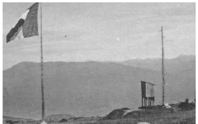
Fig. 28 - Le phare des Treize-Arbres établi en 1913 était visible de Genève et même du Jura ; ce phare comportait une caisse en bois fixée sur deux supports métalliques (seul le support nord reste depuis l'été 2003) ; une dizaine de lampes de 120 volts était alimentée par le courant destiné à la traction des automotrices
