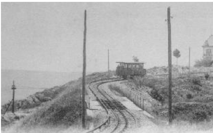
Fig. 21 - En aval de la gare principale de Monnetier-Mairie, à gauche un des poteaux de la ligne électrique d'alimentation du chemin de fer, et le pont n° 19 au-dessus de la route du Salève (vers 1900) ; au premier plan deux poteaux de la ligne téléphonique de la Compagnie
