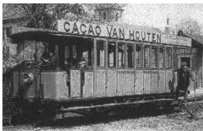
Fig. 40 - Voiture automotrice n° 3 bicolore (2 ème époque) en aval de la halte de Monnetier-Eglise ; le contrôleur bascule l'aiguille depuis le marchepied.
