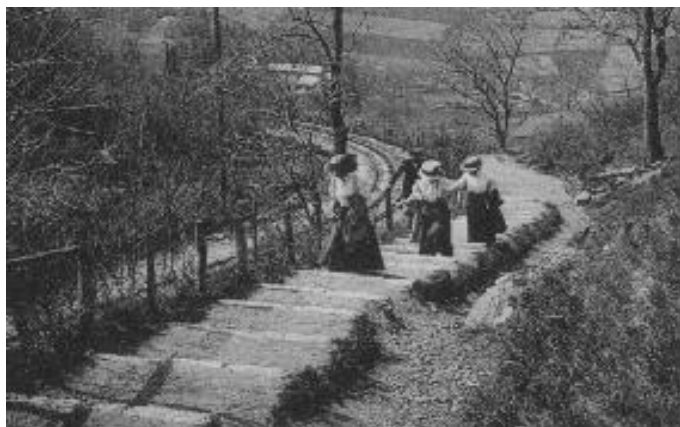
Fig. 37 - Escalier du Pas de l'Echelle réalisé lors de l'établissement de la ligne Veyrier – Monnetier en 1893 parallèlement à la voie ferrée en tranchée ; cet escalier de 100 marches remplaça le sentier serpentant dans le vallon
