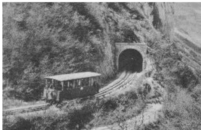
Fig. 36 - Automotrice n° 6 (1 ère époque) en amont du tunnel avant 1910
