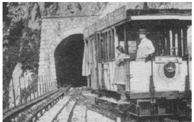
Fig. 34 - Évitement en aval du tunnel avec l'automotrice n° 2 (2 ème époque, deux couleurs) en 1918 ; sur la plate-forme aval de 2 ème classe Carmen Fontaine et son père Jules Fontaine [Voir également la Fig. 08]
