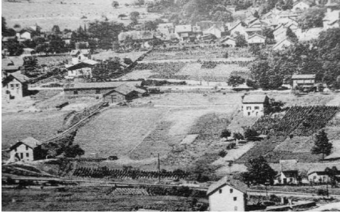
Fig. 29 - Atelier-dépôt de Veyrier à gauche (en bois) et gare de Veyrier-Salève à droite avec une automotrice garée devant ; au loin le village de Veyrier en Suisse ; au premier plan la ligne du chemin de fer PLM Bellegarde - Evian
