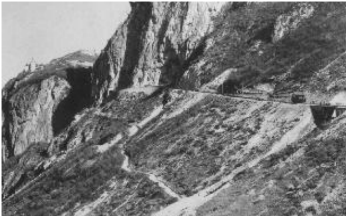
Fig. 31 - Rampe du Pas-de-l'Echelle ; le pont de la Ravine (n° 3) à droite et le sentier du Pas-de-l'Echelle parallèle à la ligne (avant 1901) ; depuis les années 1980 l'exploitation des carrières a totalement bouleversé ce paysage
