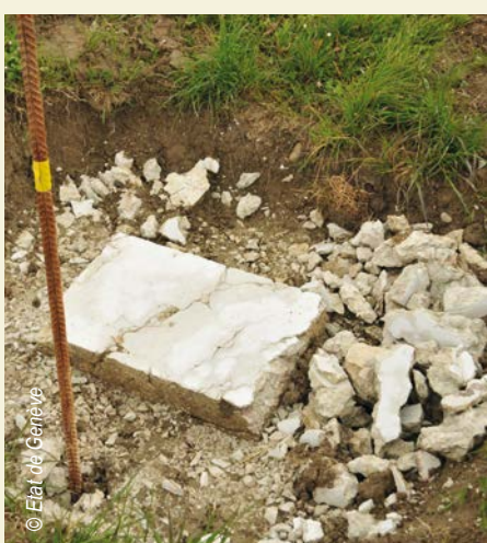
Lors de la campagne de restauration sous l'impulsion de la Fondation Re-Borne, la borne n'était plus qu'un tas de gravats.
