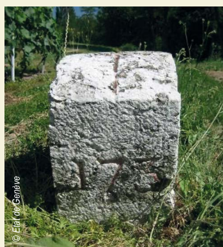
La photo prise en 2006 montre l'état de la borne qui est fissurée et se délite par morceaux.
